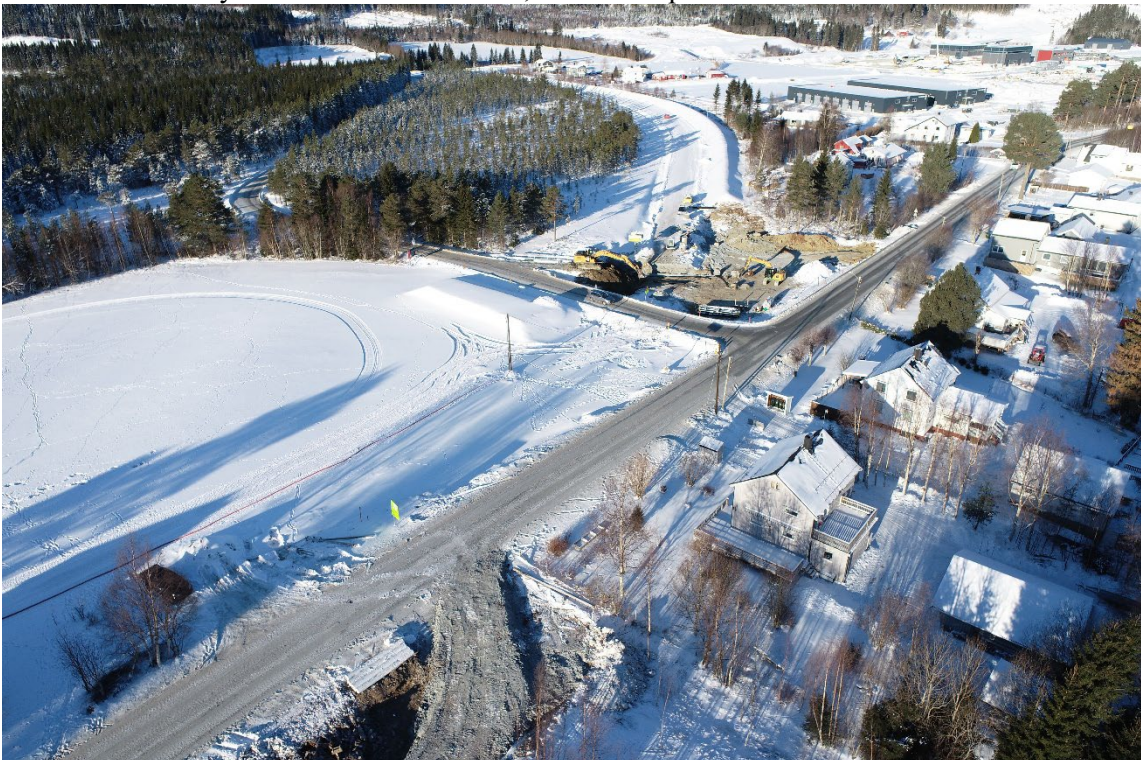
Bilde 2: Grismyrakrysset feb-24. Nytt kryss for å koble ny Fv704 til gamleveien.
