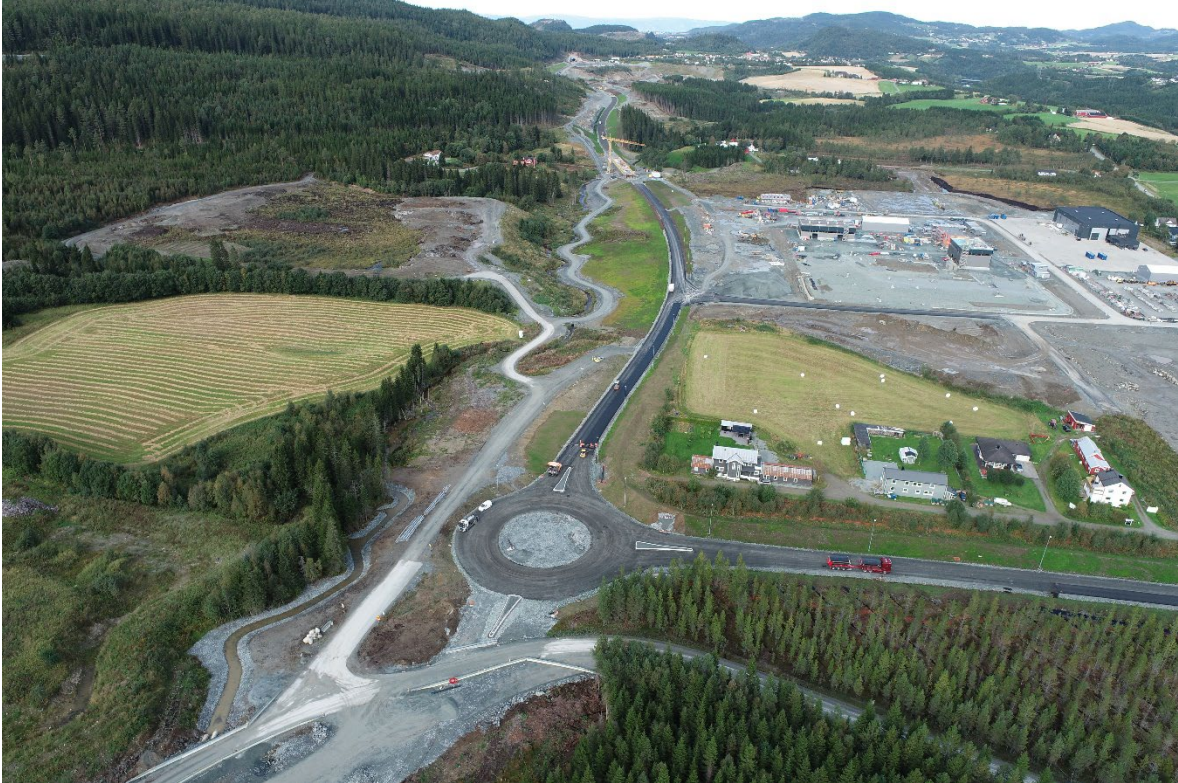
Bilde 1: Tulluankrysset sett fra sør mot nord, bilde fra sept-23
